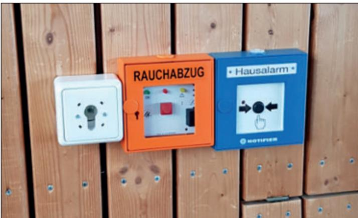
Zum vorbeugenden Brandschutz wurde eine Rauch-/Wärmeabzugsanlage (RWA) und eine Hausalarmanlage eingebaut.
