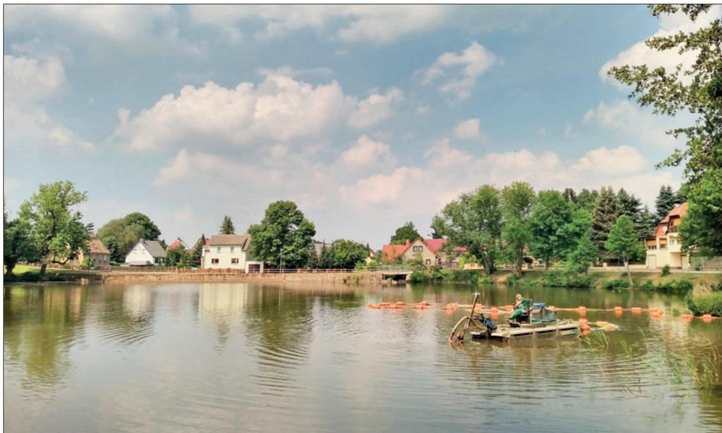
Foto: Andreas Rättsch, 2018, Entschlammung Oberfürstenteich mit Unterwassersauggerät
